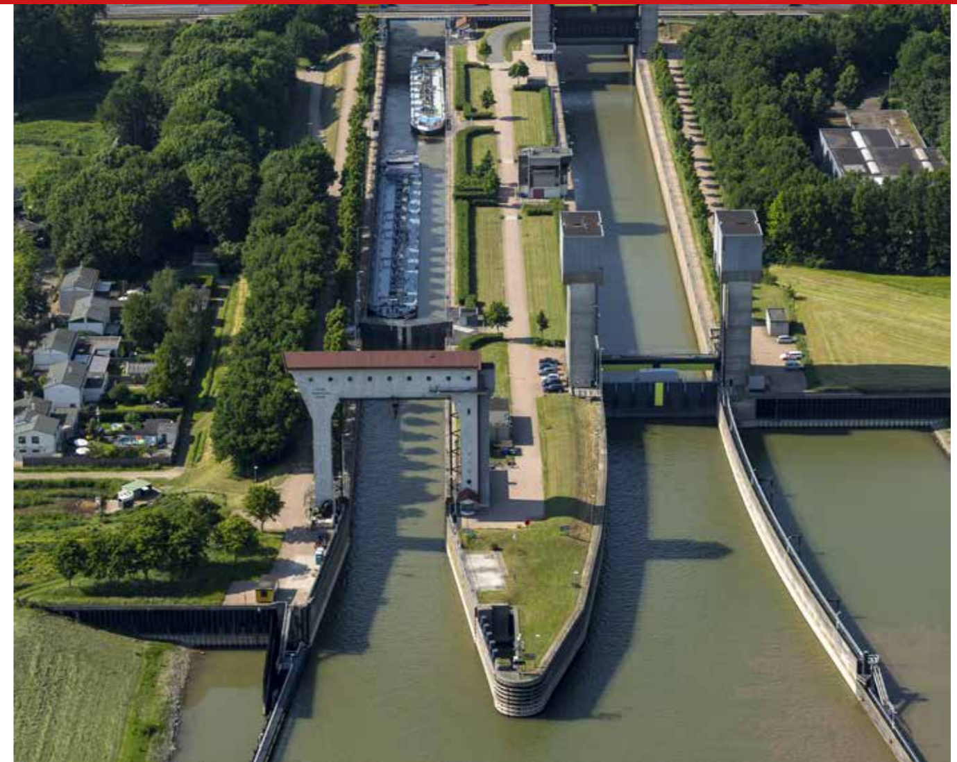
Sluiscomplexen zijn een cruciale schakel in het waterbeheer en moeten digitaal weerbaar zijn.
